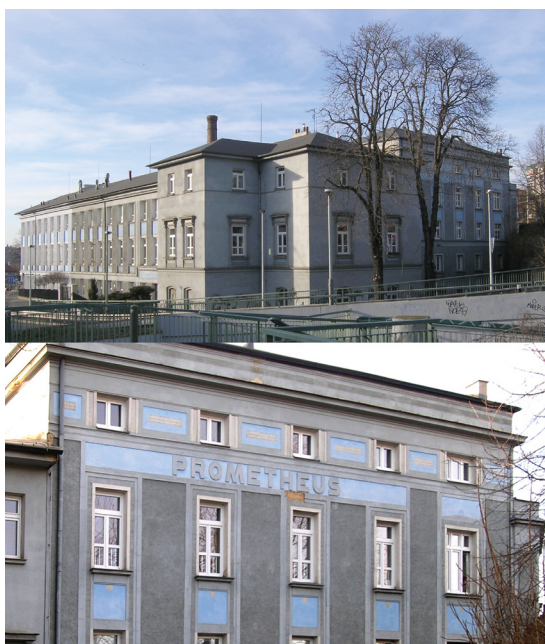
Obr. 3 Bývalá tiskárna Prometheus, dnes součást Ústavu struktury a mechaniky hornin AV ČR, jejíž fasáda „hledí“ přímo do tzv. Heydrichovy zatáčky, kde došlo v roce 1942 k atentátu. Foto: J. Valenta, leden 2012
