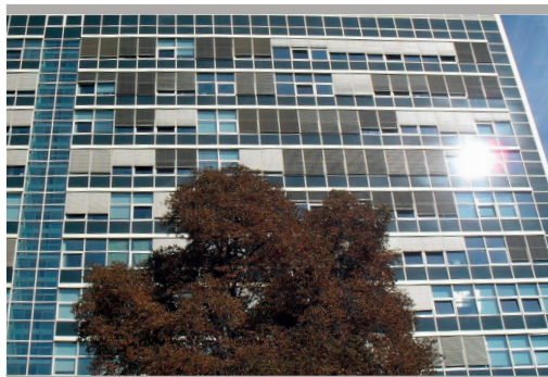
Jižní strana rekonstruovaného pláště katedrového objektu v Troji, foto P. Svoboda
