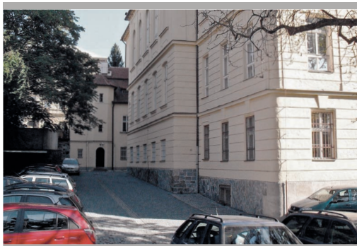
Dvůr Ke Karlovu 5 po rekonstrukci slouží jako parkoviště, foto P. Svoboda
