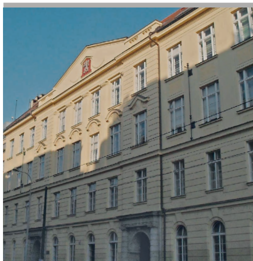
Rekonstruovaná budova MFF v Karlině, foto P. Svoboda
