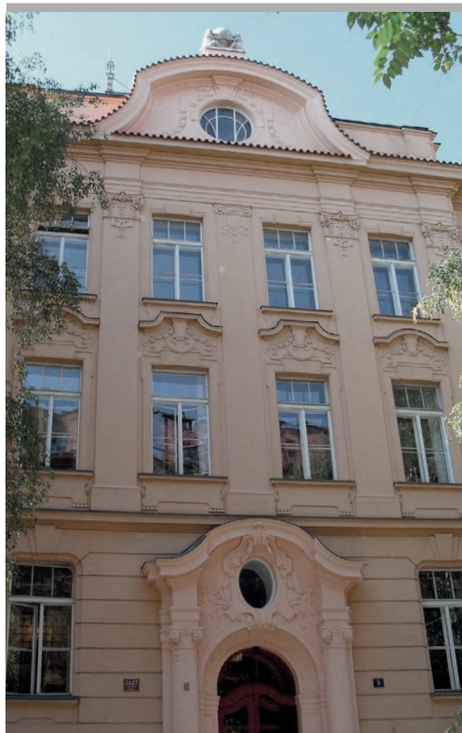
Opravená fasáda na průčelí budovy Ke Karlovu 3, foto P. Svoboda
