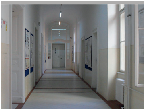
Nové podlahy na chodbách budovy Ke Karlovu 5, foto P. Svoboda
